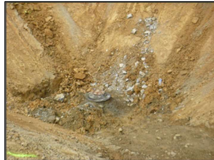
Scellement du puits
