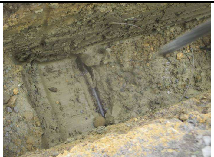
Sondage A20: P006 brai canalisation
