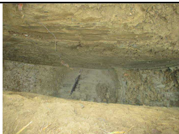
Sondage A20 : P005 brai canalisation
