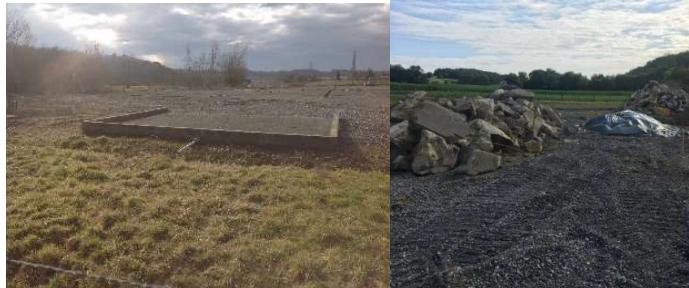
Figure 3 : Photographies illustrant le démantèlement des infrastructures de surface
