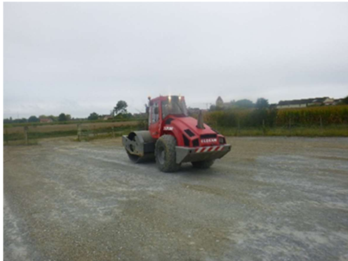
Figure 7 : Photographie de la phase de compactage
