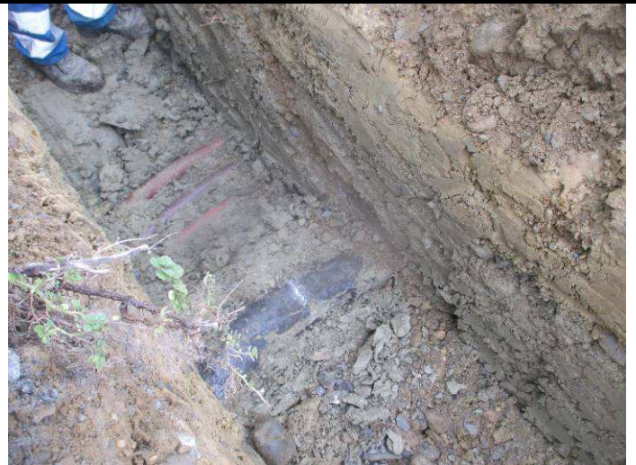
Sondage A19 : P004 brai canalisation
