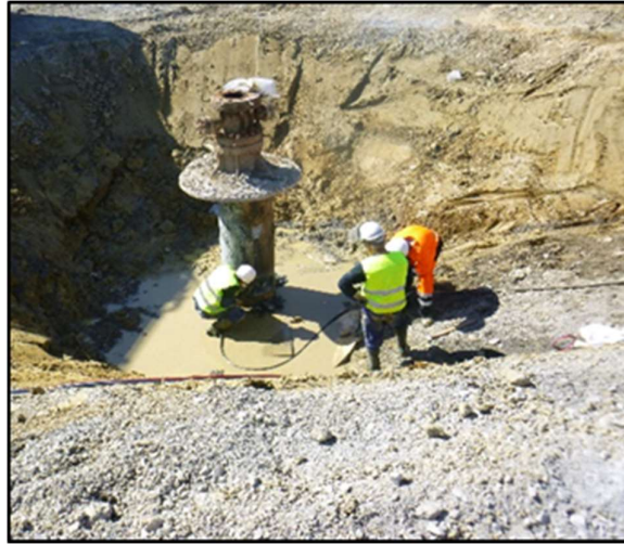
Destruction du béton et découpe au chalumeau
