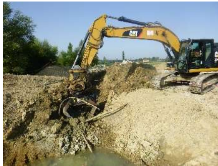
Figure 4 : Photographie illustrant le retrait des réseaux enterrés
